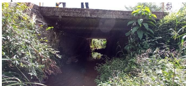
Figura 96: Vista do PA 14, localizado a montante do perímetro urbano. Vista da ponte a montante da Av. 20 de Março.
