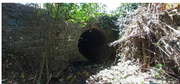
Figura 77: Vista do PA 05, localizado a montante da Rua Carlos João Grando, vista da tubulação do PA05, de montante para jusante.
