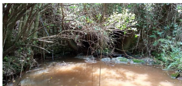
Figura 92: Vista do PA 12, sobre a Rua Professor Germano Laroceski, saída da tubulação.
