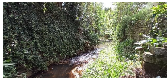
Figura 97: Vista do PA 14, localizado a montante do perímetro urbano. Vista da galeria a jusante da Av. 20 de Março.
