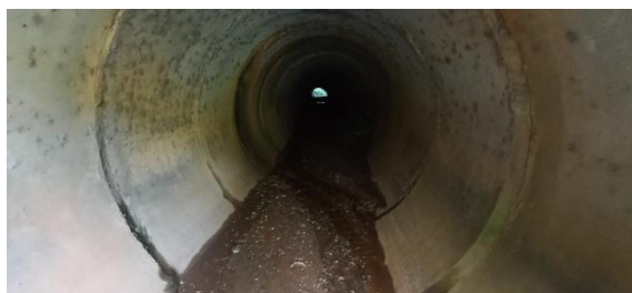
Figura 70: Vista do PA02, de montante para jusante.
