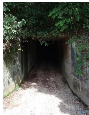
Figura 103: Vista do túnel que atravessa a ferrovia. Vista do túnel usado para passagem de pedestres e veículos.
