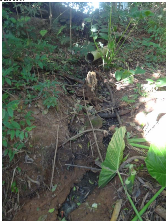
Figura 17: Exemplo de ligação de esgoto direto para o Arroio.
