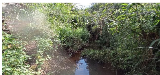
Figura 99: Vista do PA 11, localizado a montante do perímetro urbano. Saída da tubulação, é possível visualizar a quantidade de material dentro da tubulação da esquerda da fotografia.
