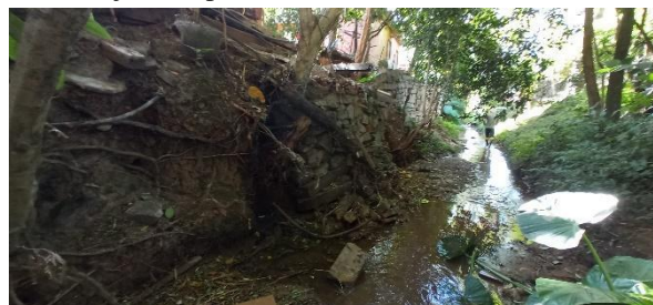
Figura 69: Vista do PA02, a jusante da Avenida, com sentido de jusante para montante.
