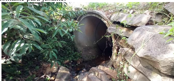
Figura 87: Vista do PA 10, localizado a montante do perímetro urbano. Vista da tubulação do PA10, de montante para jusante.
