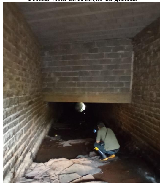
Figura 94: Vista do PA 13, localizado sob a Rua João Pressi, vista da redução da galeria.
