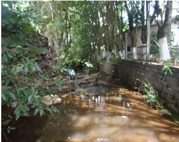
Figura 13: Trecho com solo aluvionar, ponto onde existe risco de desabamento de um galpão da prefeitura.
