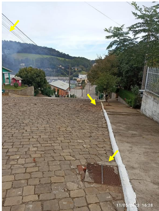
Figura 110: Infraestrutura e serviços urbanos. Ponto na Avenida Luiz Spolti, demonstrando a infraestrutura, a via corta dois afluentes do Arroio Gabriel – PA04 e PA07.
