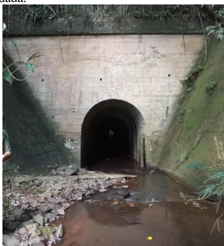
Figura 100: Vista do PA 16, localizado a montante do perímetro urbano. Vista do PA em formato de porta arredondada.
