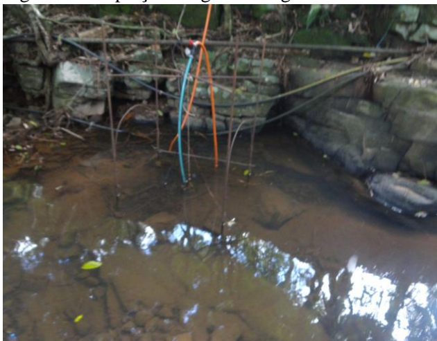
Figura 17: Exemplo de ligação de esgoto direto para o Arroio.
