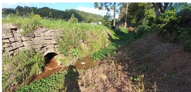
Figura 74: Vista da tubulação das águas do banhado localizado no centro, trata-se de tubo de concreto com diâmetro de 60cm. A montante da Rua Jacó Chiodelli, com sentido de jusante para montante, mostrando a tubulação do banhado e o canal do arroio.
