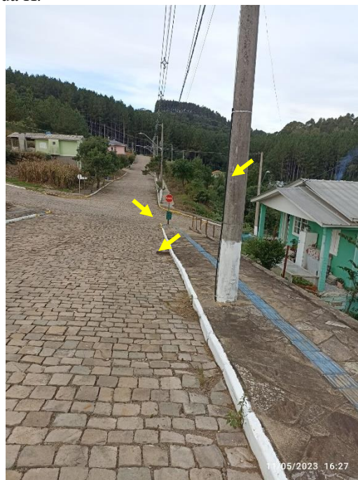
Figura 113: Infraestrutura e serviços urbanos presente na rua K.
