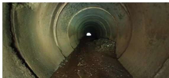
Figura 71: Vista do PA02, porção no final da tubulação.
