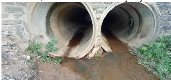
Figura 73: Vista do PA03, a jusante da Rua Jacó Chiodelli, com sentido de montante para jusante.
