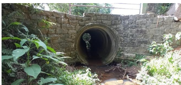
Figura 79: Vista do PA 06, localizado a montante da Rua Carlos João Grando, de montante para jusante.
