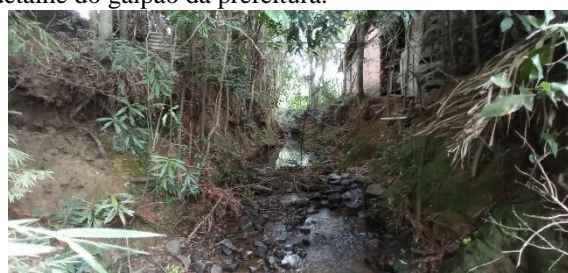
Figura 80: Vista do PA 06, localizado a montante da Rua Carlos João Grando, a montante do PA06, com detalhe do galpão da prefeitura.
