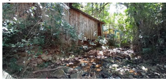
Figura 78: Vista do PA 05, localizado a montante da Rua Carlos João Grando, vista do canal do Arroio Central, a montante do PA05, com detalhe do galpão da prefeitura.
